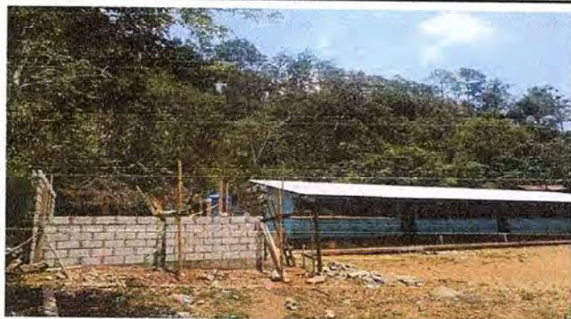
Foto 7: evidencia del 20% de avance del remozamiento de la cocina
