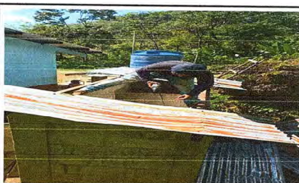
Foto 10: ahí se puede ver el cambio de láminas de los baños.
