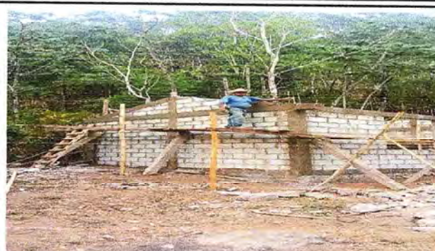
Foto 8: 80% de avances la sustitución de pared en bloks
