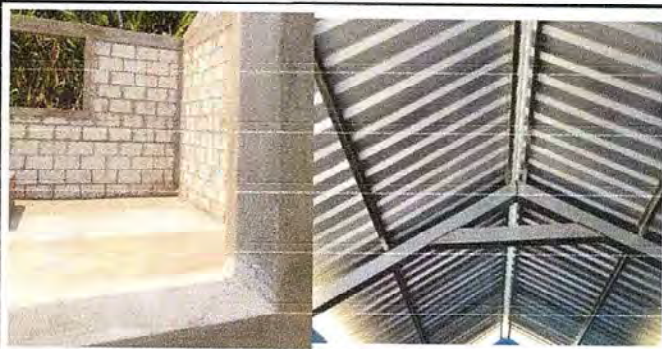
Foto 9: 90% de avances, Sustitución e instalación de costaneras y láminas troqueladas calibre 26, y el piso de torta de concreto.
