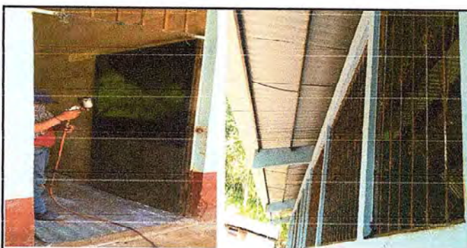
Foto 11: pintura de puertas y balcones.
