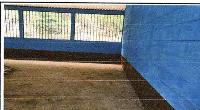
Foto 12: evidencia del establecimiento donde se pintó la parte interior del muro y el zocalo.
